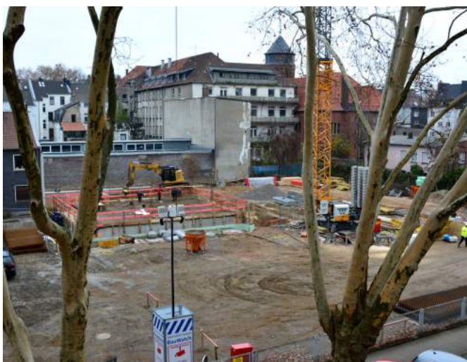
Nach dem Abriss des alten Gemeindehauses und der Entfernung von Altlasten im Erdreich haben die Bauarbeiten auf dem ehemaligen Gelände der Lydia-Gemeinde begonnen.
